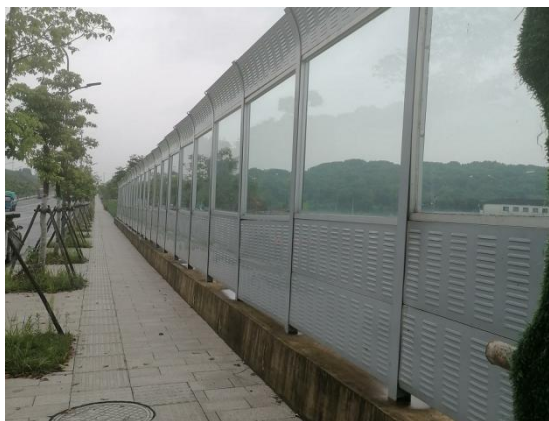
图 7.4-2 声屏障安装情况
