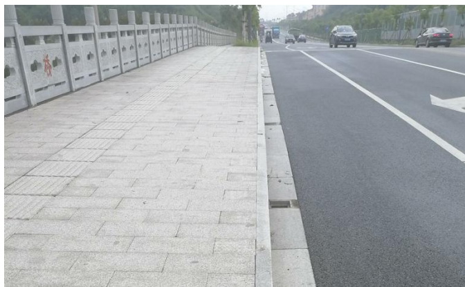
图 8.2-3 桥梁处路面形式
