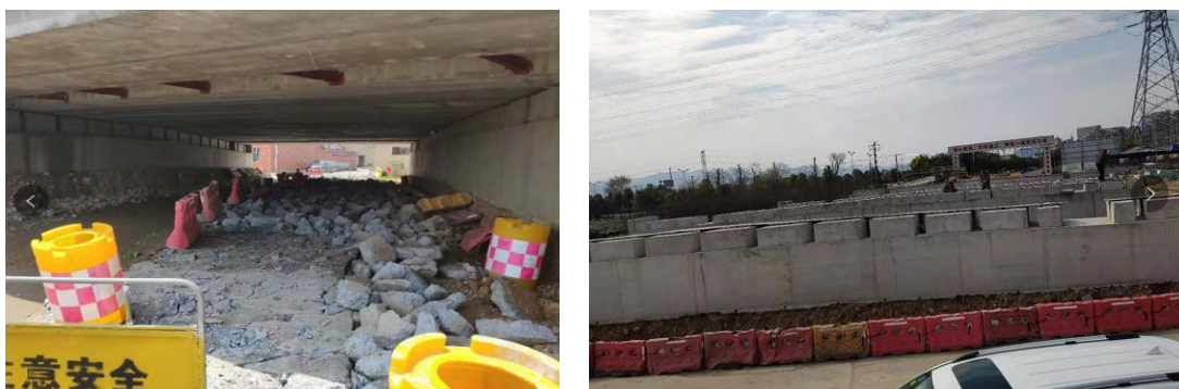
图 8.2-4 项目桥梁现场图
